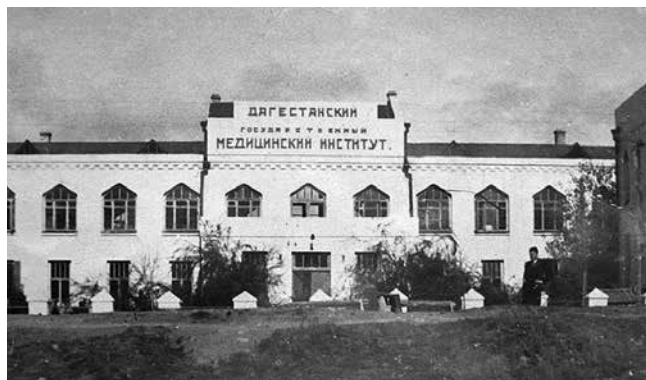
Корпус Дагестанского медицинского института. Конец 1930-х годов Building of Dagestan Medical Institute. End of the 1930s
